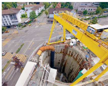
Schacht Brunnenhof (Zürich Oerlikon)
